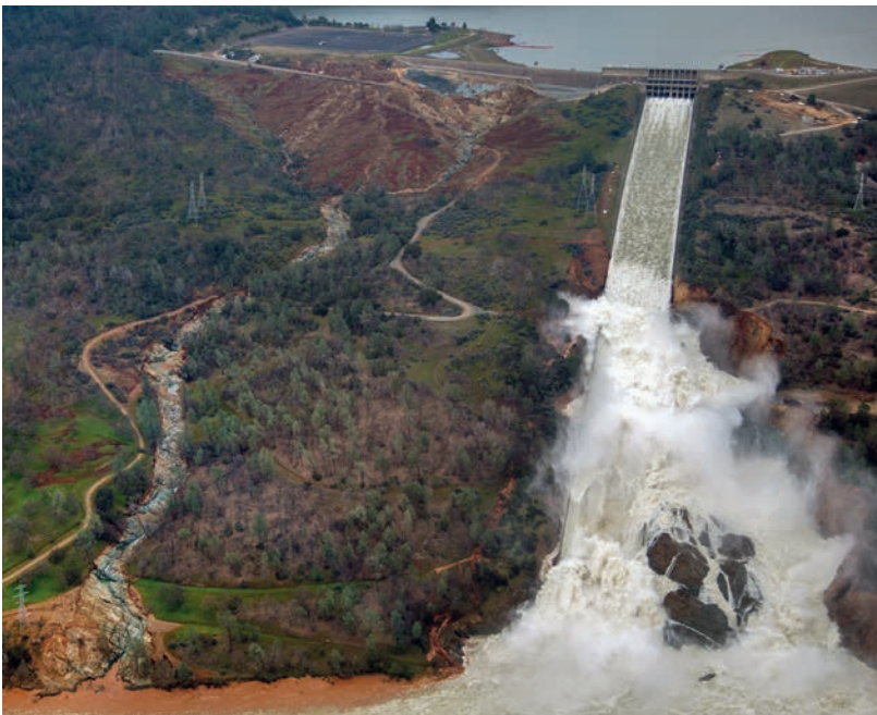
Abb. 5 Situation am 15. 2. 2017. Der Abflussstrom hat sich bereits in den frischen, harten Felsuntergrund eingeschnitten; die Gischt ist nicht mehr orangebraun gefärbt. Links der Abflussweg unterhalb des Notfall-Wehrs; die graue Farbe deutet an, dass auch hier die Erosion bereits im frischen Felsuntergrund wirkte. (Foto/Credit: Dale KOLKE/California Department of Water Resources)
