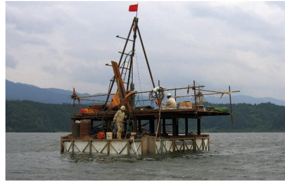
Abb. 2 Bohrplattform auf dem Suigetsu-See, 2006. Foto: Achim BRAUER/GFZ.
